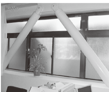
移譲後、行われた耐震工事
