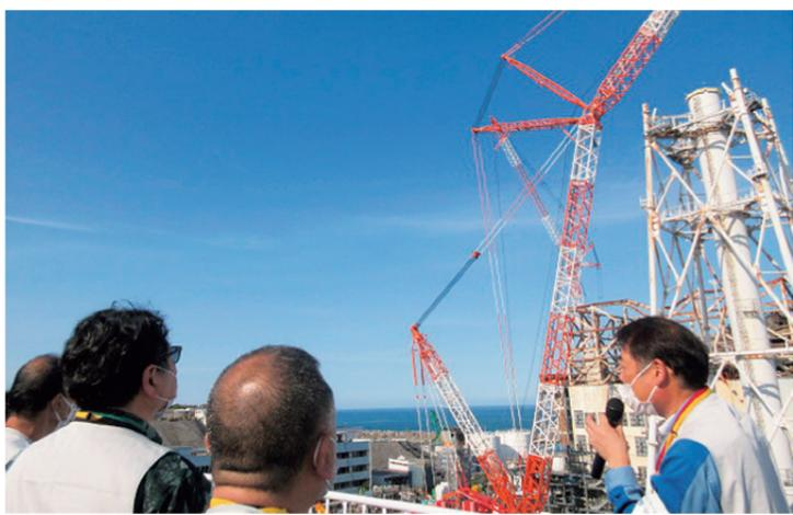
線量の高い瓦礫で撤去作業が進まず、大型カバー設置に向けクレーン作業中の1号機
