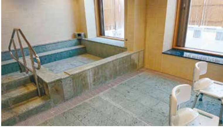
病棟に設置された温泉風呂には、十和田石を使用
